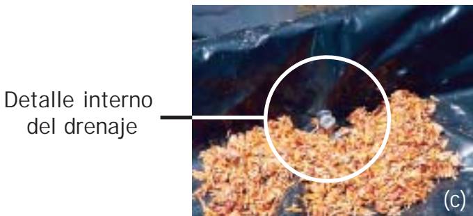
Fig. 5 (a, b, c). Construcción y detalle interno de drenaje.
